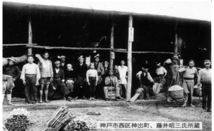
セメント樽製造風景(1910年撮影) 大きな柱の右寄りに丸鋸が見える
